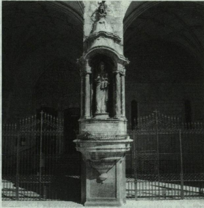
Aspecto general del Pórtico de San Miguel
